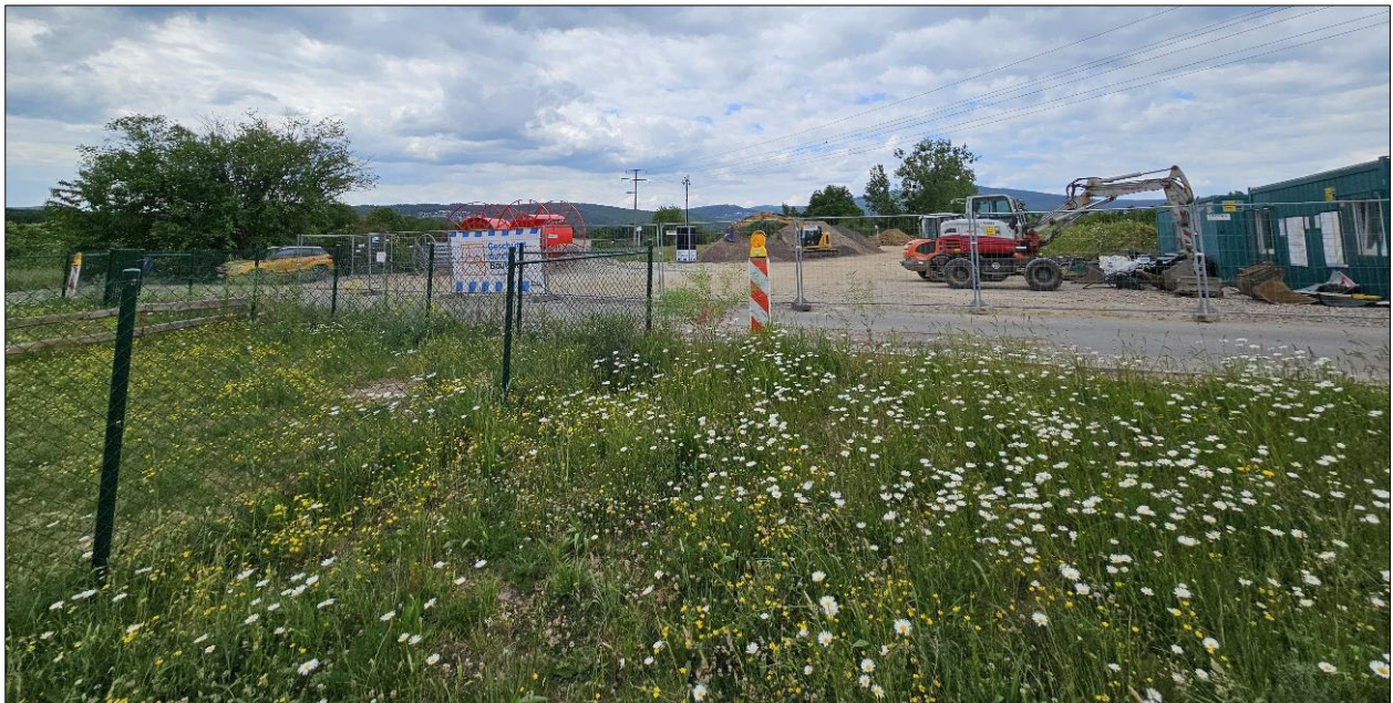
Abbildung 17: Lager- und Baustelleneinrichtungsfläche im Nordwesten des Plangebiets (Foto: IBU 17.05.2025).
