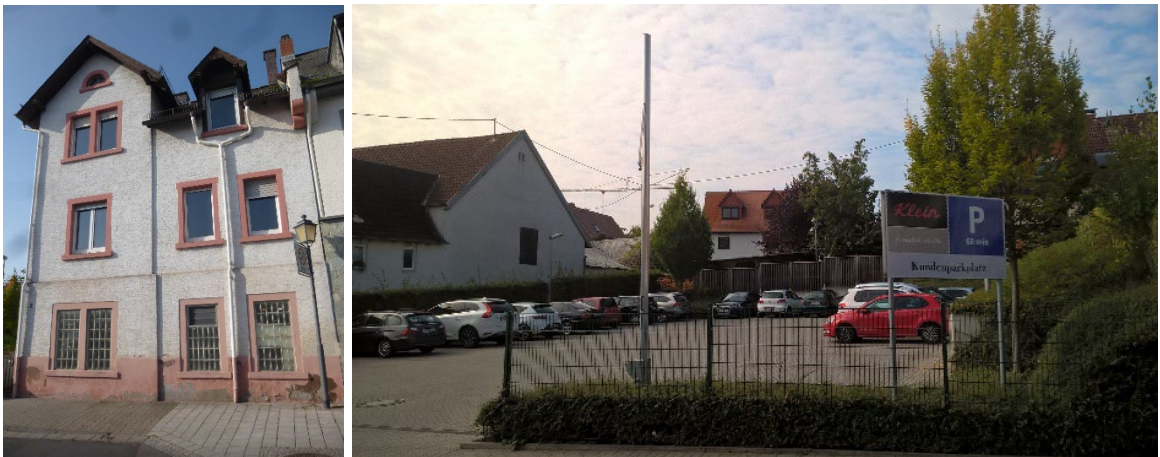
Abbildung 8: Sodener Straße 2 und südlich angrenzender Parkplatz
