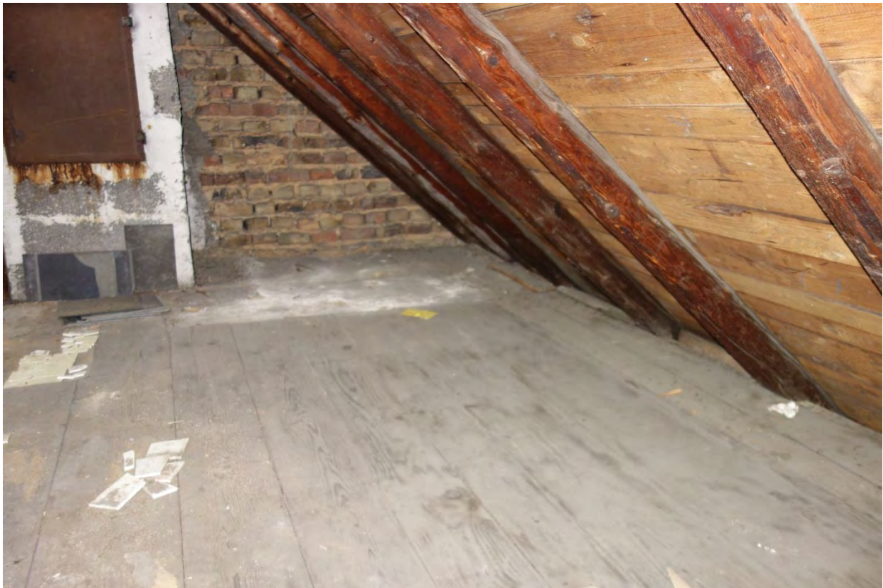
Foto 9 Dachboden des Hauses Sodener Straße 2a
