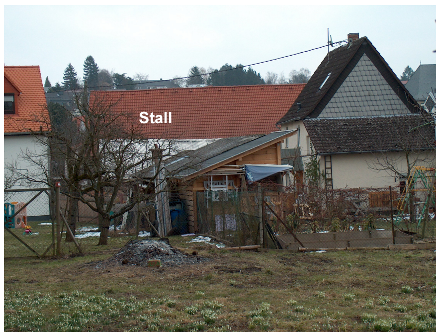
Ansicht aus westlicher Richtung mit dem Wohnhaus Sodener Straße 8
