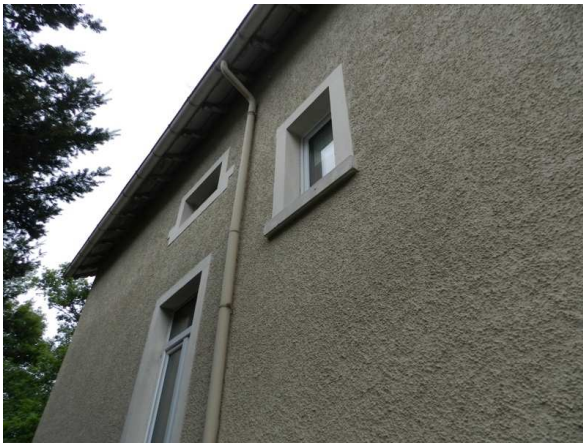
Foto 7: Dichte Fassade des Wohnhaus Schillerstraße Nr. 2. Äußerlich kein Quartierpotenzial für Tiere.
