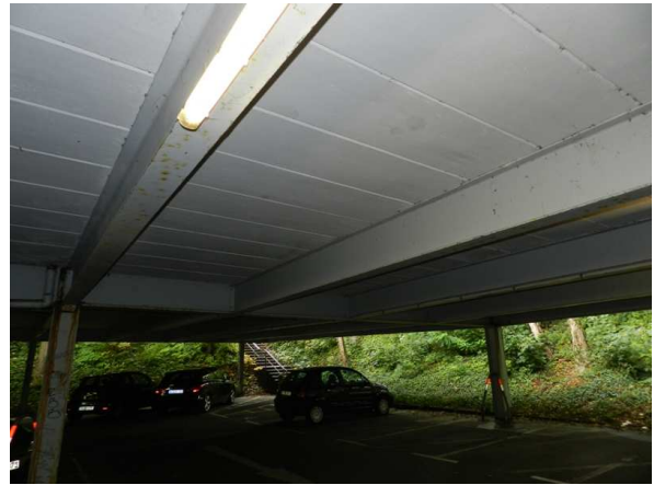
Foto 8: Erdgeschoss des Parkdecks. Es sind keine Vogelnester auf den Stahlträgern vorhanden.
