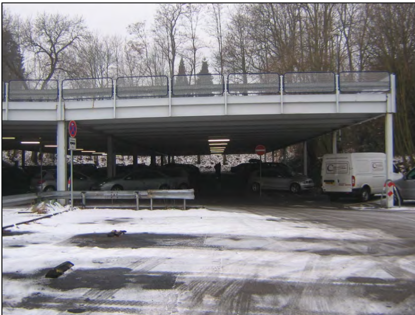
Abb. 2: Parkdeck mit asphaltierten Verkehrsflächen
