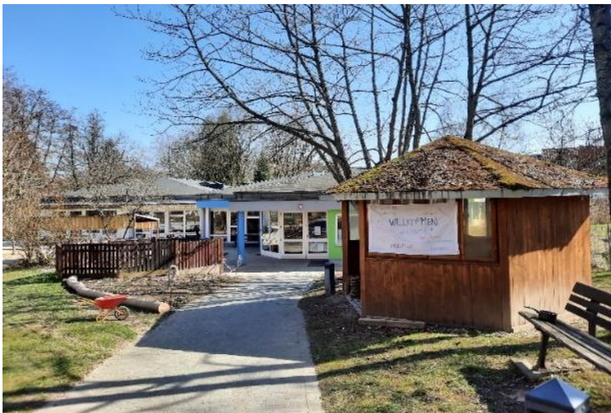
Abbildung 16 Kita Pustablume (Eingangsbereich)
