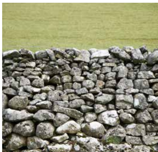
Ringwall als Böschungsmauer
