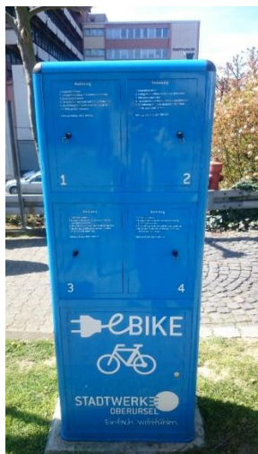
Abbildung 14: Ladestation für Pedelec-Akkus (Foto: R+T)
