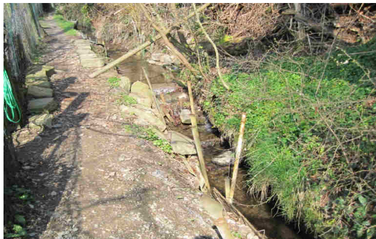
Rentbach I: Eingengter Bachlauf mit improvisierter Uferbefestigung
