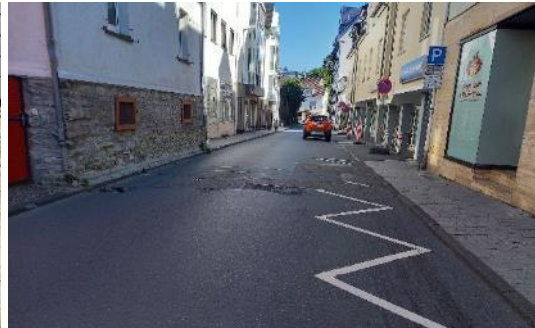
Abbildung 36: Unzureichende Gehwegbreiten in der Schillerstraße (Schöenberg)
