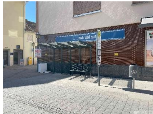
Abbildung 53: Fehlender Hochbord zum niveaugleichen Einstieg (Haltestelle „Dalles“ in Oberhöchstadt)
