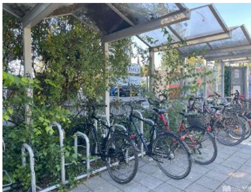
Abbildung 103: Fahrradabstellanlage am Bahnhaltepunkt Kronberg Süd
