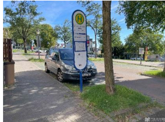
Abbildung 51: Fehlende Einstiegsmöglichkeit in den Bus an der Haltestelle „Kirche“ (Oberhöchstadt)
