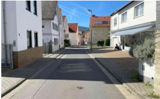
Abbildung 35: Unzureichende Gehwegbreite in der Oberurseler Straße (Oberhöchstadt)
