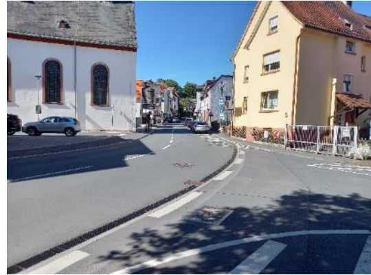
Abbildung 138: Überdimensionierte Knotenpunkte mit langen Querungswegen (z.B. Friedrichstr./Wiesenu)
