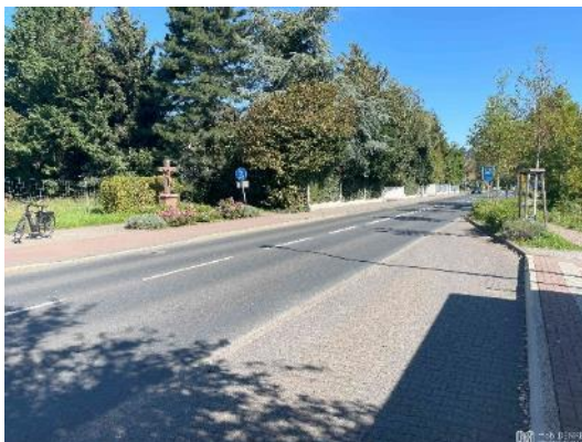
Abbildung 129: Fehlende Querungsstelle im Bereich der Haltestelle „Sodener Straße“
