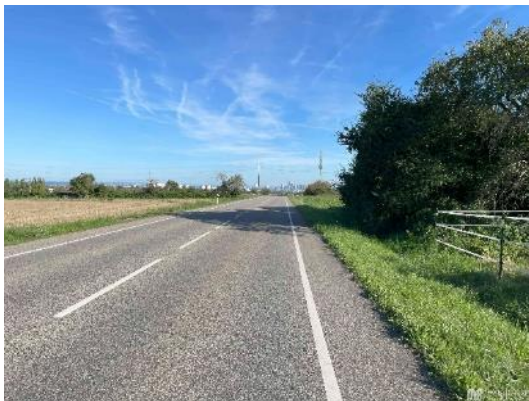
Abbildung 32: Fehlender Gehweg entlang der K 768 (Niederhöchstädter Straße)
