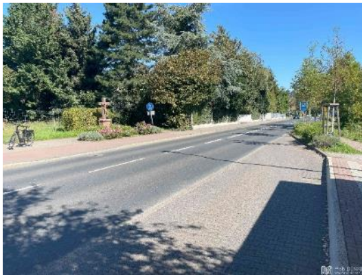
Abbildung 117: Fehlende Querungsstelle im Bereich der Haltestelle „Sodener Straße“
