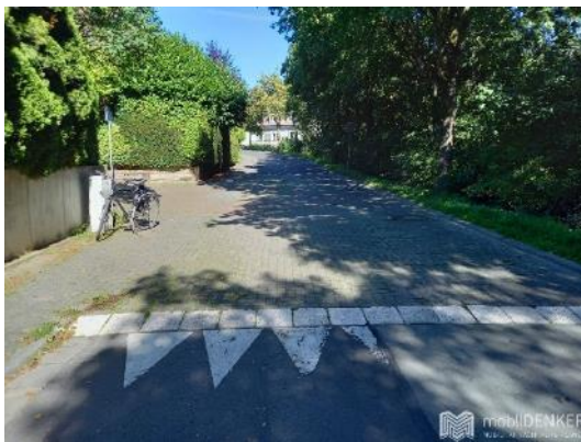
Abbildung 63: Knotenpunkt mit Aufpflasterung und „Haifischzähnen“ (Trennprinzip)
