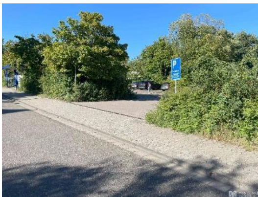
Abbildung 131: Unzureichende Sichtbeziehungen an den Parkplatz-Zufahrten
