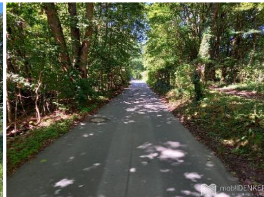
Abbildung 33: Fehlender Gehweg „Im Kronthal“
