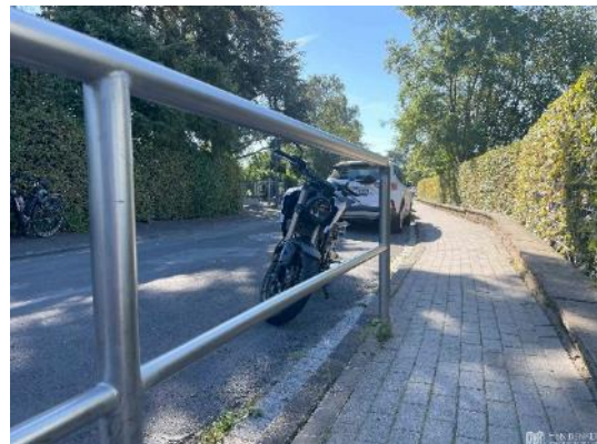
Abbildung 126: Deutlich unterdimensionierter Gehweg am Eingang der Grundschule „Schöne Aussicht“
