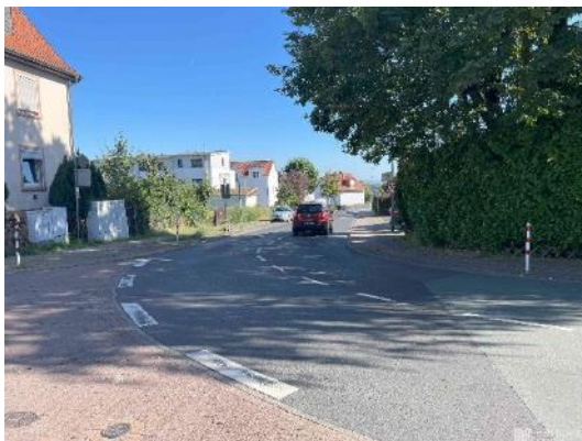
Abbildung 42: Fehlende Barrierefreiheit am Knotenpunkt „Schönberger Straße/ Limburger Straße“ (Oberhöchstadt)
