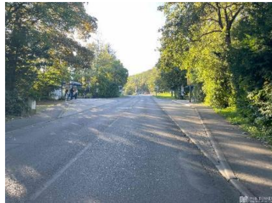
Abbildung 118: Fehlende Querungsstelle an der Haltestelle „Falkensteiner Stock“ (Königsteiner Str.)
