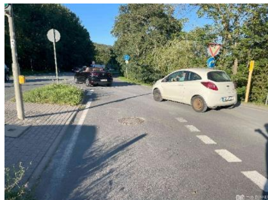
Abbildung 104: Fehlende/ verblasste Furtmarkierung und Roteinfärbung (gem. Geh-/Radweg am Opel Zoo)
