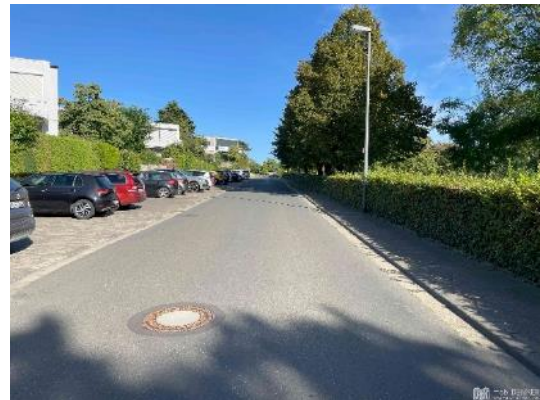
Abbildung 60: Fehlende Einheit von Bau und Betrieb in der Steinbacher Straße (Oberhöchstadt)
