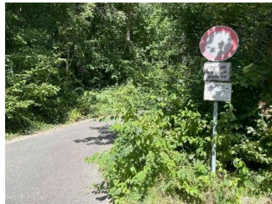
Abbildung 72: Fehlende Freigabe für den Radverkehr (Landesnetz Hessen; Am Waldschwimmbad)
